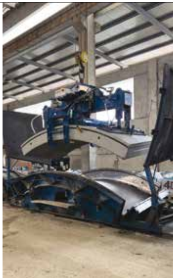
3. L'operazione di scassero dopo la maturazione di 24 ore
