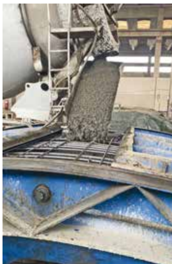
2. Il getto di calcestruzzo nel cassero dove è già stata posizionata la gabbia in ferro
