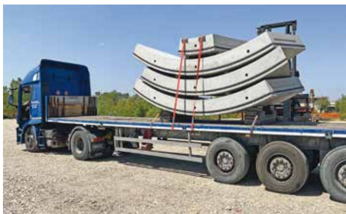
4. Il camion caricato con i conci e pronto per il trasporto verso la galleria
